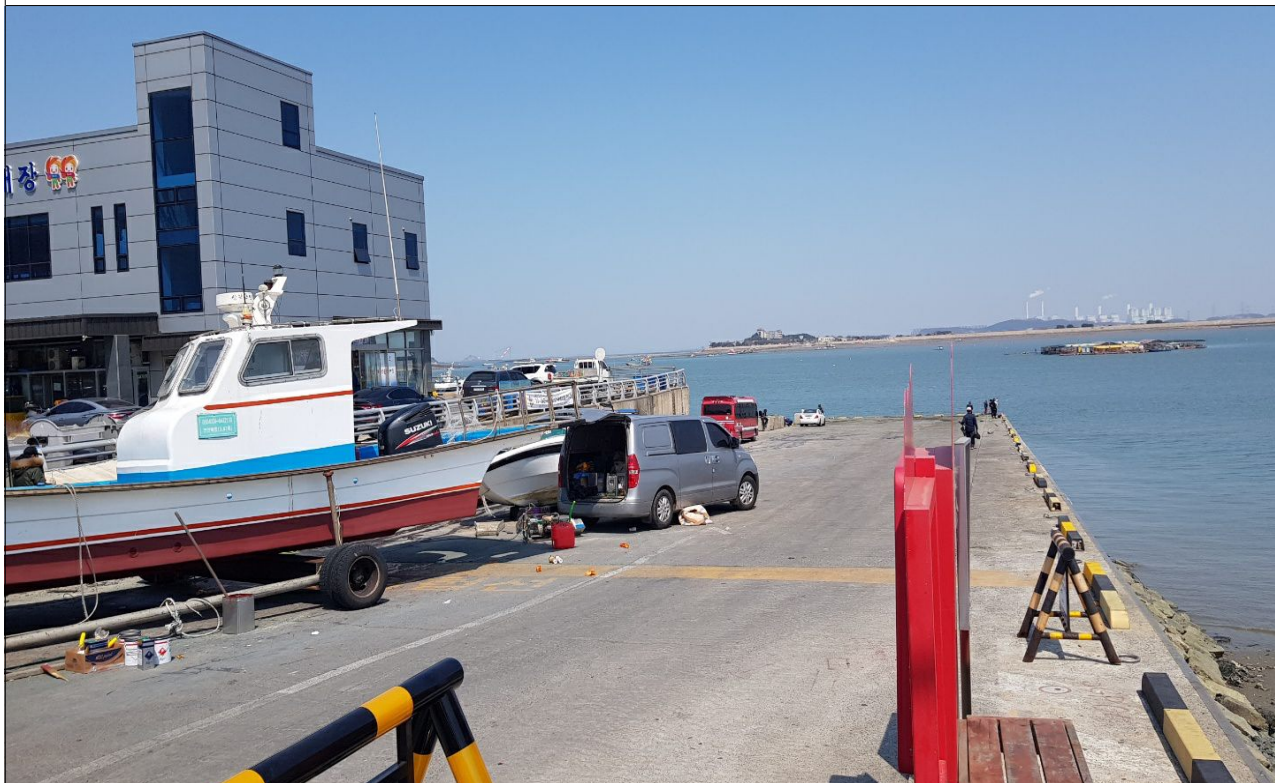
삼길포항 선착장 현장사진
